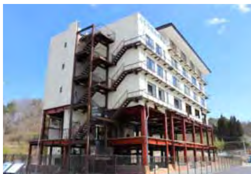
全国初の震災遺構・旧田老観光ホテル。学ぶ防災の重要な施設となっている。
