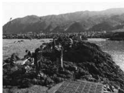
八丈島底土港での調査
