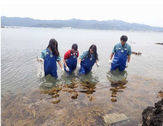
【建材ブロックを設置しているところ】
