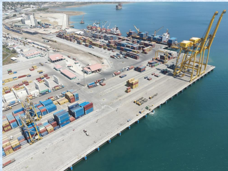
JICAによるODA事業： モザンビーク基幹港・ナカラ港整備
