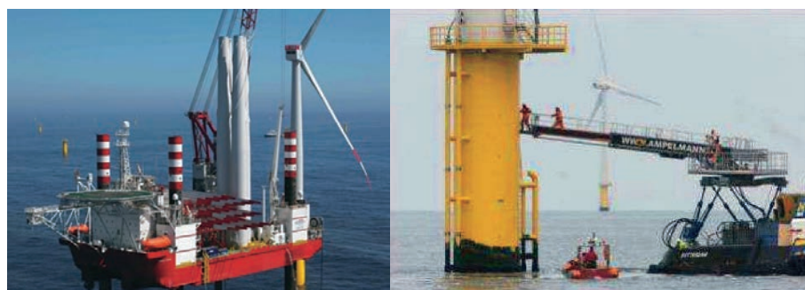
図3-2-3 左：建設専用船（SEP）による洋上風車の据付作業 右：油圧式乗陸橋を備えた洋上風車のメンテナンス船 （出典：左 Seajacks、右 Ampelmann）
