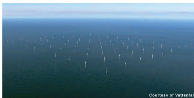
図3-2-1 デンマークのホーンズ・レブ洋上風力発電所 (2002年運開、2 MW風車×80台、出典 Vattenfall 社)
