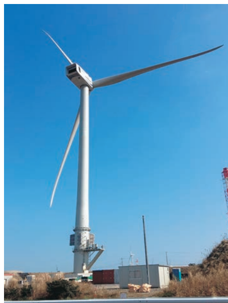
鹿島湾深芝風力発電所の「HTW 5.0-126」初号機 (出典：日立製作所 http://www.hitachi.co.jp/New/cnews/month/2015/03/0324.html )
