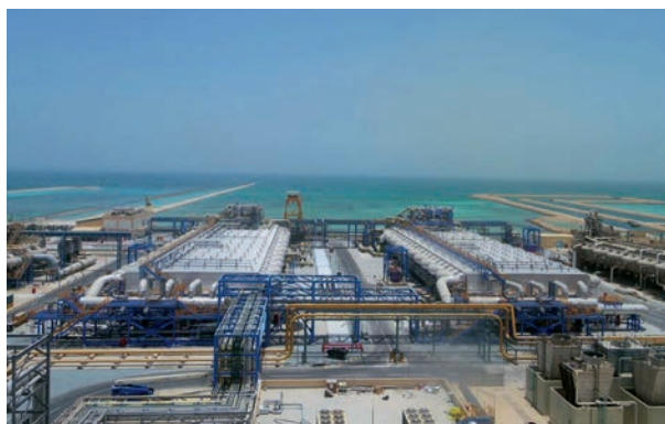
建設工事を完工した大型海水淡水化プラント
