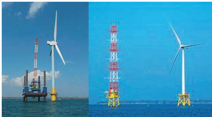
図3-2-4 銚子沖の2.4MW風車(左)と北九州市沖の2MW風車(右) (出典: NEDO)
