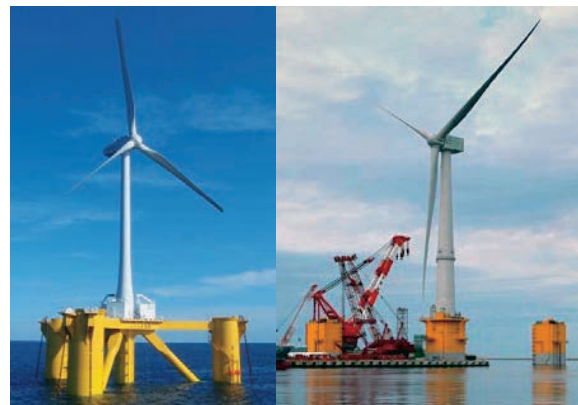
図3-2-5 福島沖の2MW風車と7MW風車(左: 福島未来、右: 福島新風) (出典: 福島洋上風力発電コンソーシアム)
