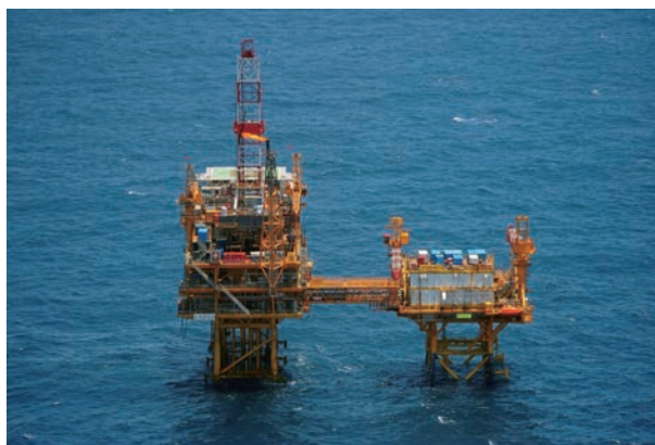
土台の設置が確認された構造物 (出典：外務省)
