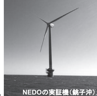
【洋上風力発電設備のイメージ】
