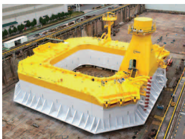
完成した次世代浮体式洋上風力発電システムのバージ型浮体 (出典：NEDO)
