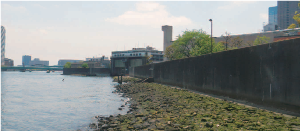
図4-1-7 高潮防潮堤（右側のコンクリート壁）と高潮防潮水門（中央の構造物）を組み合わせ建設した事例
