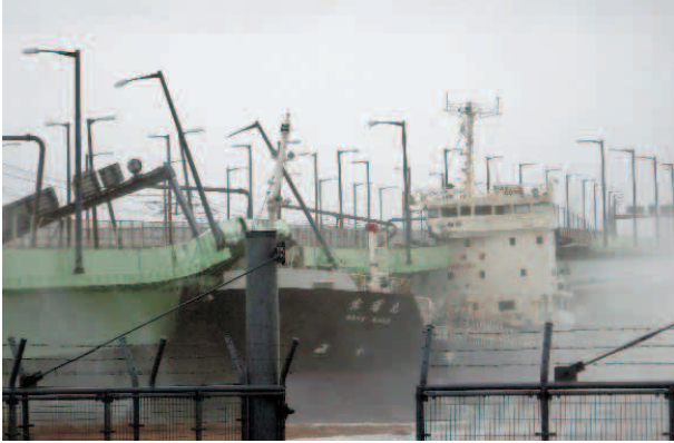
図4-2-6 走錨して連絡橋に衝突したタンカー
