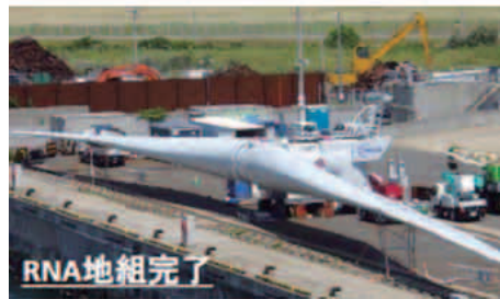
図3-2-9 ナセル・ブレードの地組状況 (出典：NEDO)
