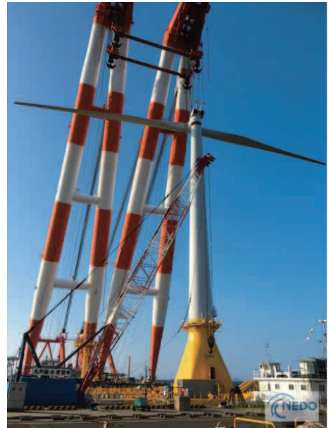
図3-2-10 タワーの設置状況 (出典：NEDO)
