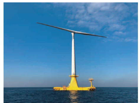
図3-2-12 実証海域に設置された実証機「ひびき」、直径は100m (出典：NEDO)
