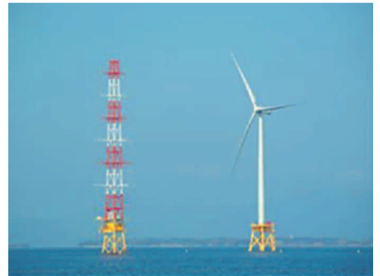
銚子沖洋上風力発電所（出典：NEDO）
