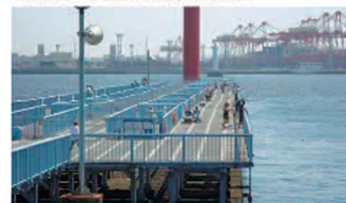
<新潟港>東港区第2防波堤
