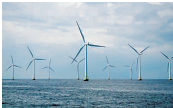
図1-1-2 Hornsea One 洋上風力発電所
