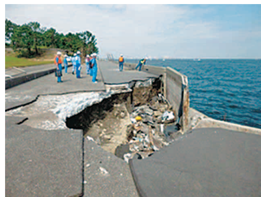
図5-1-4 台風15号で被災した横浜市金沢区の護岸 (注12)
