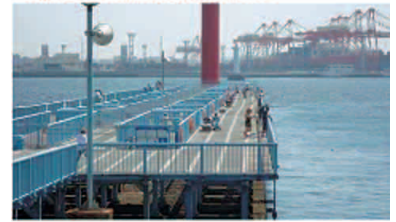
<新潟港>東港区第2防波堤
