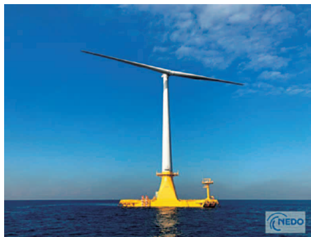
図1-1-3 NEDOの次世代浮体式洋上風力実証プロジェクト
