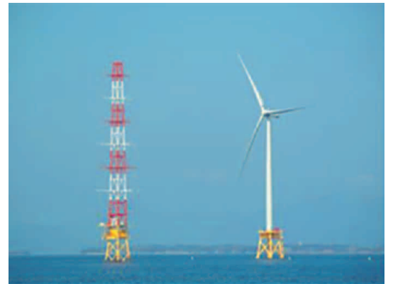
銚子沖洋上風力発電所（出典：NEDO）
