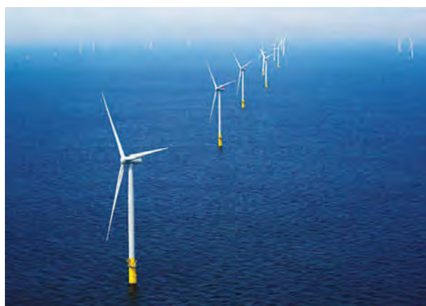
図4-1-1 オランダの Borsselle 1 & 2 洋上風力発電所 2020年運転開始、8,000kW 風車×92基、出力75万2,000kW （出典：Ørsted）
