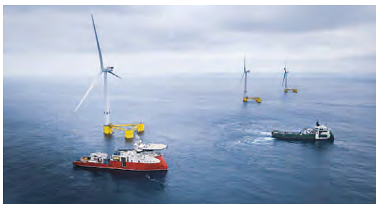
図4-1-6 WindFloat Atlantic 浮体式洋上風力発電
