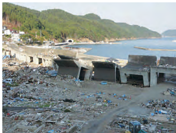
図5-3-2 海岸堤防の破壊と沿岸集落の被災(岩手県釜石市唐丹町)
