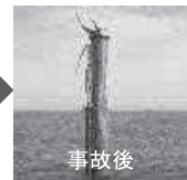
走錨船舶の接触による損傷（灯標の上部脱落） ※過去5年間における船舶接触による航路標識の被害件数 計262件
