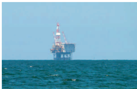
図5-1-2 岩船沖に見える油ガス田のプラットフォーム
