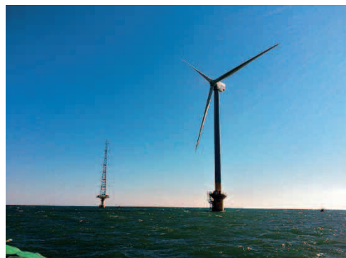
銚子沖の洋上風車発電
