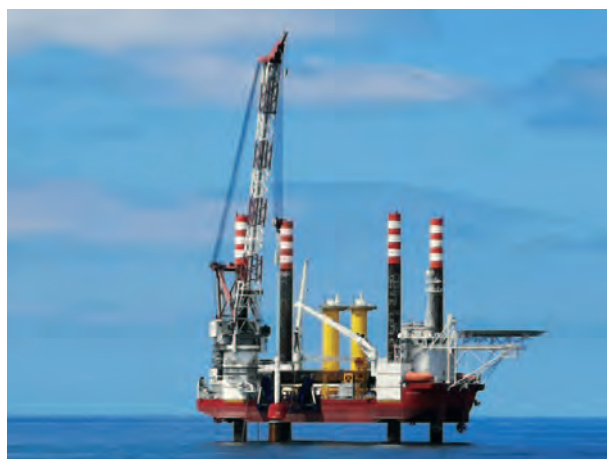
図1-2-1 基礎部分の杭の打設の様子 (出典：秋田洋上風力発電㈱)
