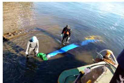
外板用 IWC 装置の設置
