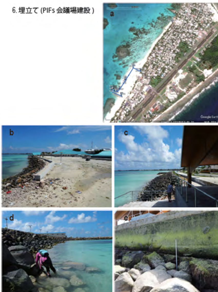
図 8 : PIFs 会場の埋立てエリア、護岸の置石
