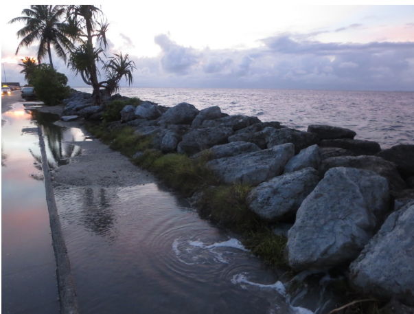
写真1 高潮の発生時に堤防の隙間から陸地に流入する海水 (RMI・マジロ)
