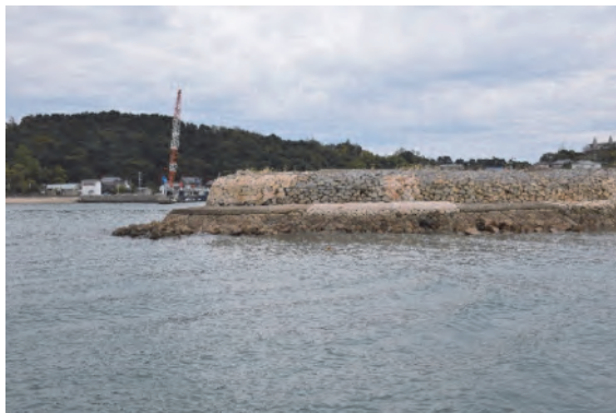
300年前に構築された堤防 (復元されたものだが基礎部分は昔の石)
