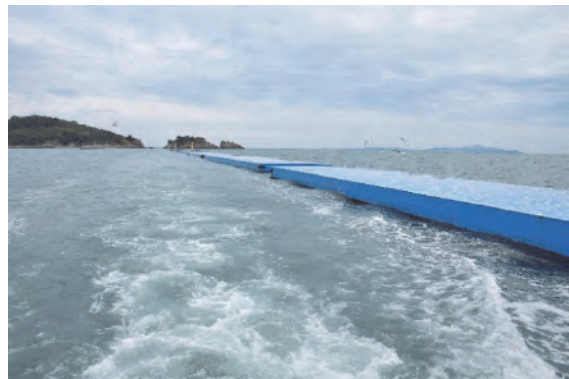
海洋牧場沖に設定された浮消波堤防
