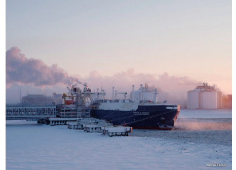
■ヤマルのLNG船荷役作業(写真: ©Novatek)
