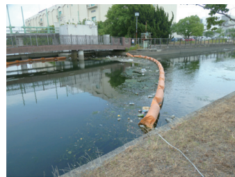
図2 岡山市内の西川用水下流、オイルフェンスと除塵機でごみを回収(2019.6.5.筆者撮影)
