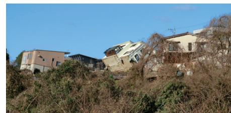
写真2 金沢市田上新町の盛土の崩壊(2024年1月2日撮影)
