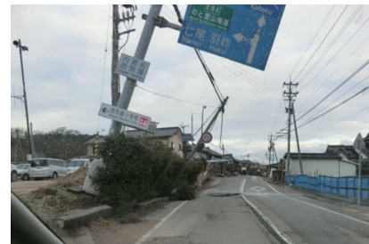
写真1 内灘町西荒屋の液状化被害(2024年1月15日撮影)
