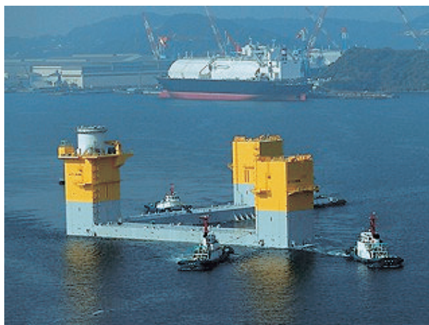
長崎港内を曳航される 7 MW 油圧ドライブ型浮体式洋上風力発電設備用浮体 (出典：福島洋上風力コンソーシアム)
