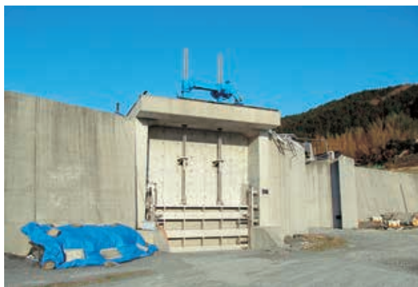
扉つきの防潮堤
