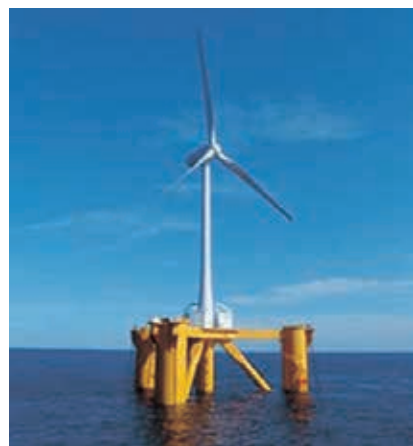
2 MW 浮体式洋上発電設備
