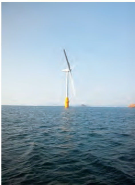
図3-4-3 環境省事業五島沖浮体式洋上風力の実証実験
