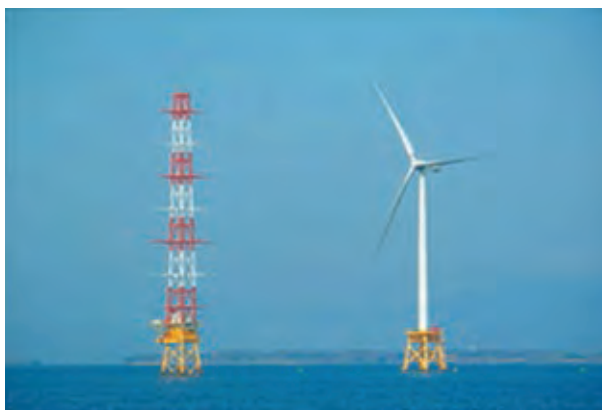
洋上風況観測タワー
