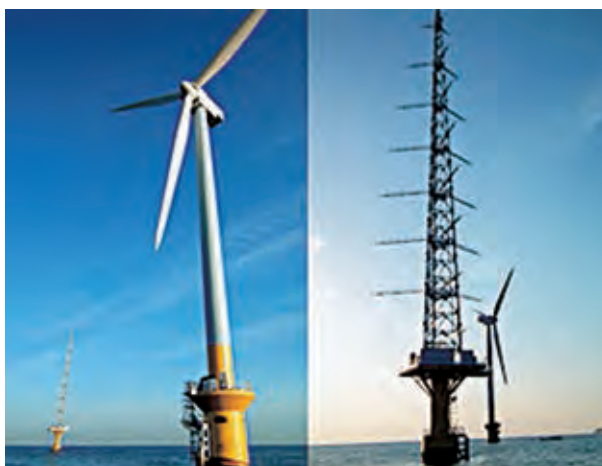
着床式洋上風力発電設備
