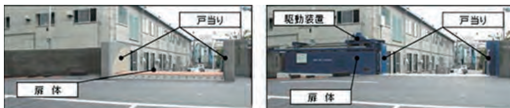
フラップゲート式防潮堤
