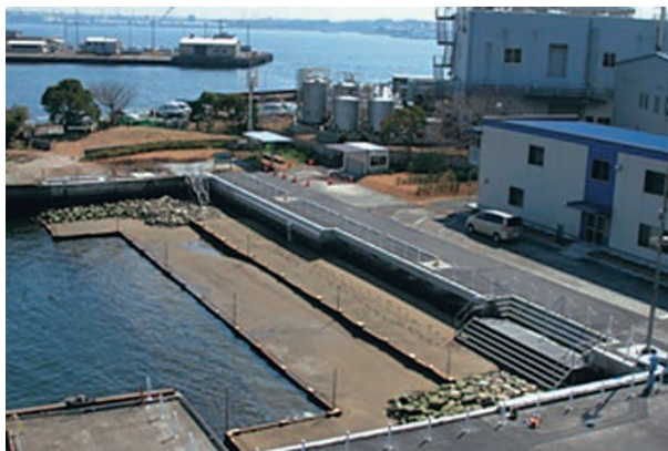
図2-7 横浜港の一角に完成した「潮彩の渚」
