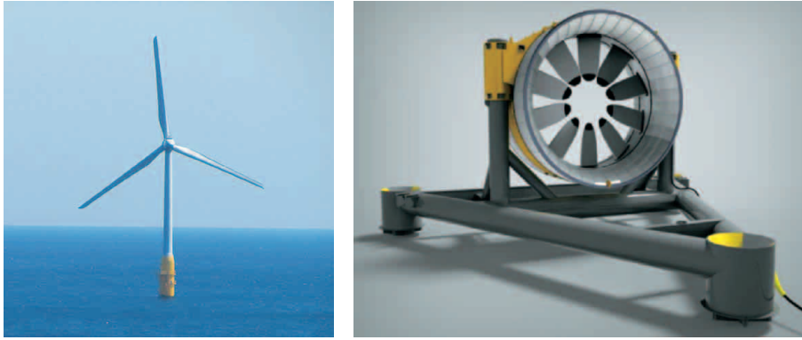
図3-2-2 環境省の事業により設置された浮体式洋上風力発電施設（左）と設置が予定される潮流発電機（右）
