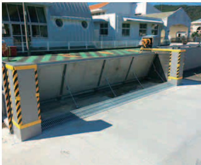
図5-3-4 陸上式可動型防潮壁（ネオライズ）
