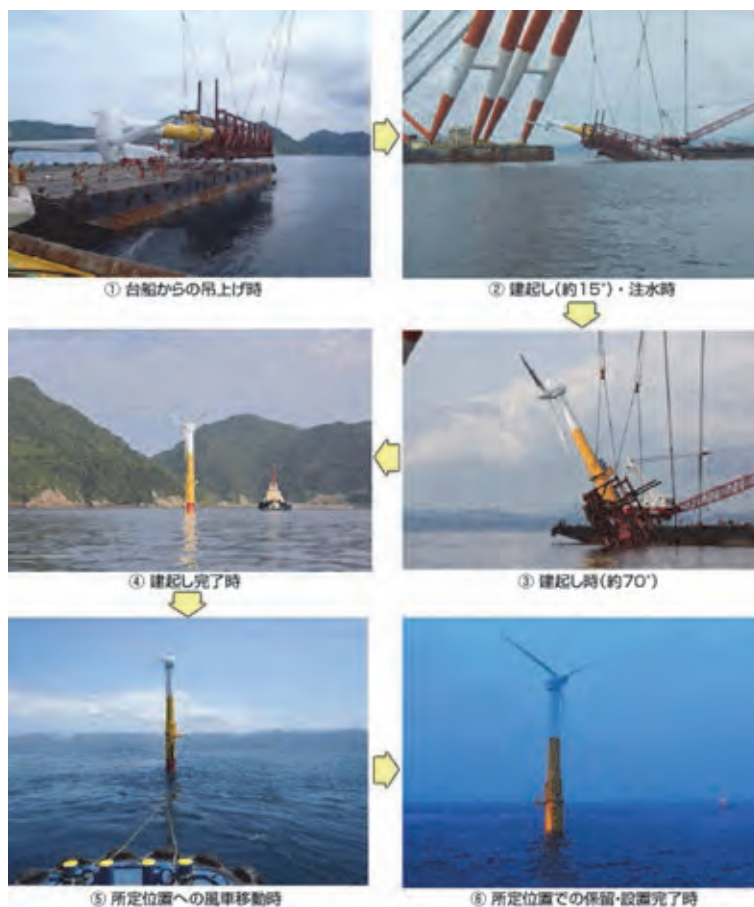
浮体式洋上風力発電施設の洋上設置状況
