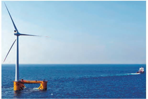
浮体式洋上風力発電施設
