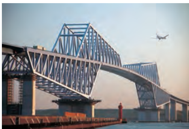
東京ゲートブリッジ
