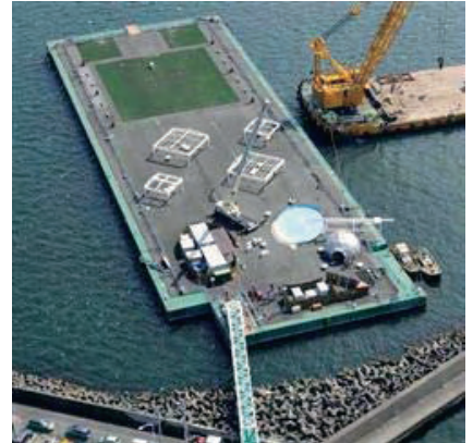
汚染水を一次貯蔵するためのメガフロート
