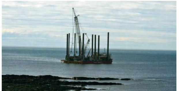
波力発電装置設置のための台船
