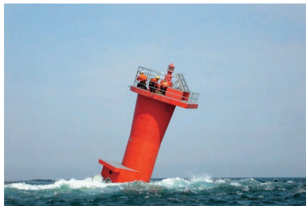
図1-2-13 震災により傾斜した灯台
