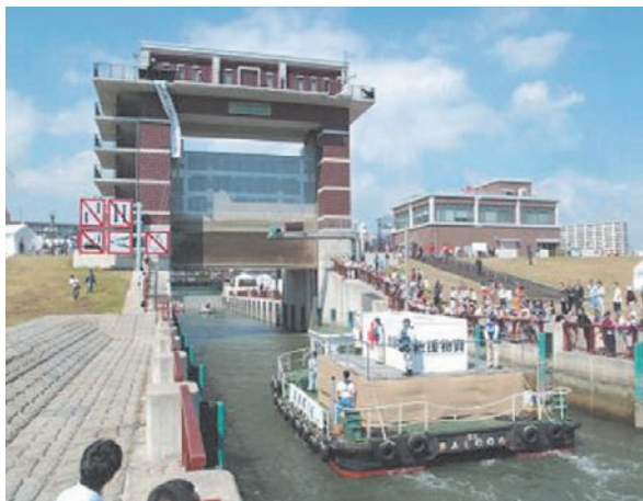
図2-15 荒川ロックゲート
