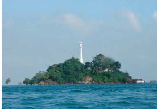
図4-4-5 マラッカ海峡の安全を守るタコン灯台
