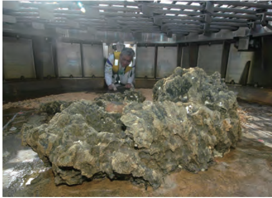
図1-1-4 コンクリート護岸とチタン製ネットで守られている沖ノ鳥島東小島
