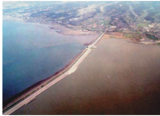
図2-2-6 上空から見た諫早湾潮受け堤防 (2003年4月18日)
