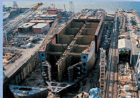
図2-23 ドック内で建造中のダブルハルタンカー
