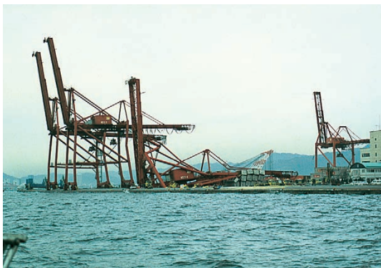
図1-7-4 地震で倒壊した六甲アイランド・コンテナパークのクレーン
