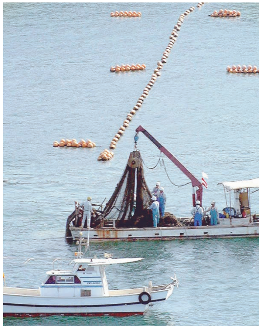
図1-3-1 撤去される水俣湾の仕切り網
