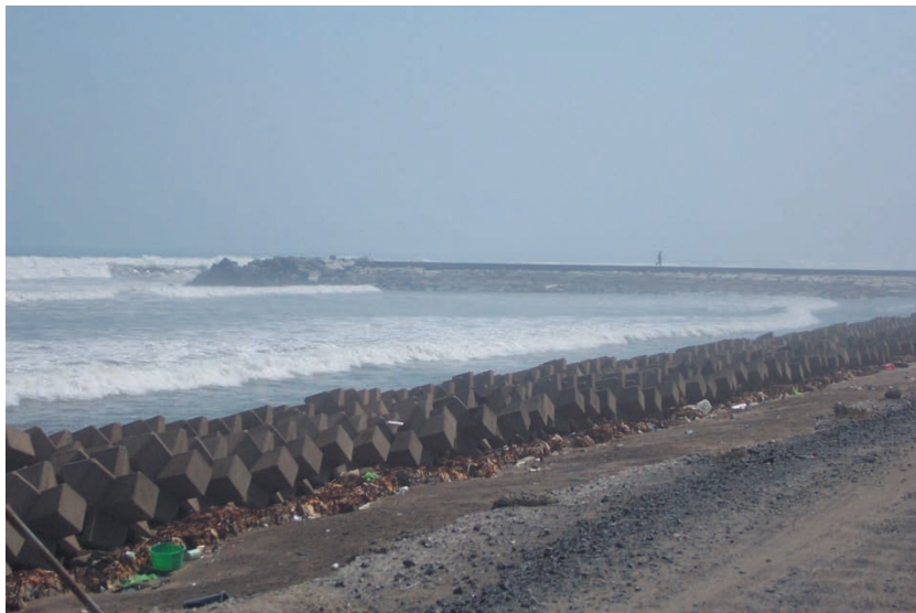
図1-3-4 海岸侵食対策として砂浜にならぶ消波ブロック
