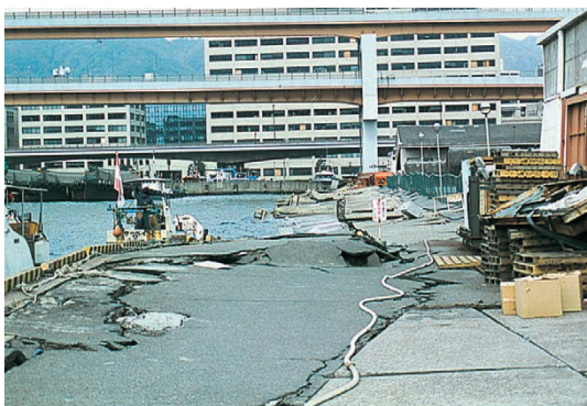
図1-7-5 地震で倒壊した三宮付近の岸壁
