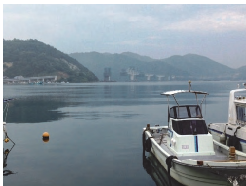
図 2-12 建設中の備前♡日生大橋
