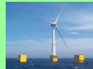
7MW浮体式風車 「ふくしま新風」
