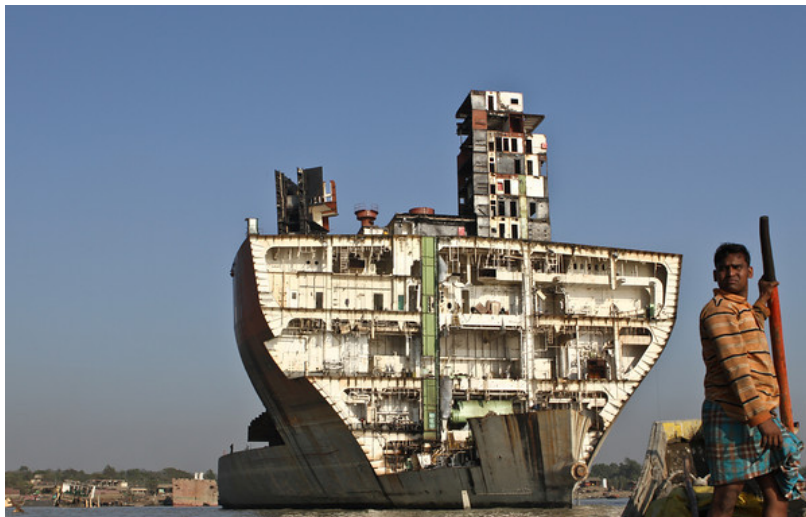
バングラデシュの船舶解撤作業現場
