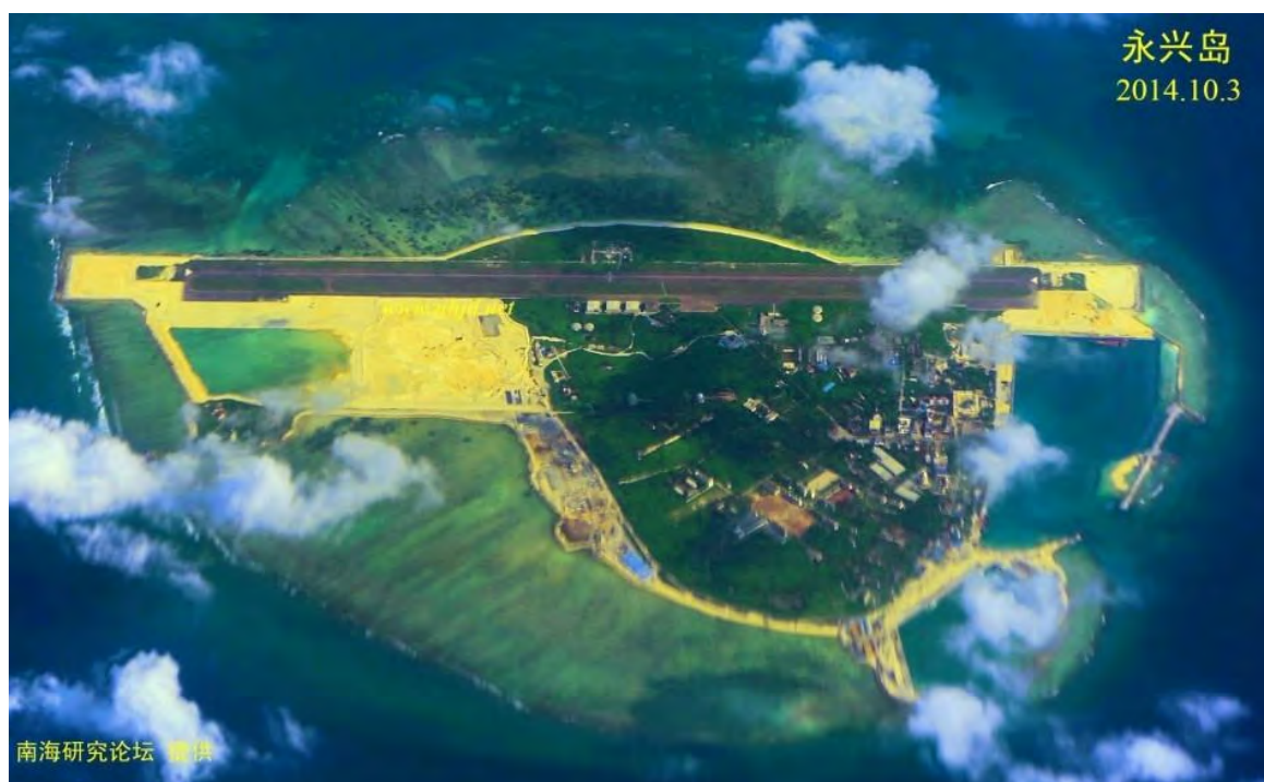
【図表 5：ウッディー島の滑走路拡張工事の状況】
