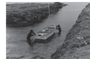
魚釣島西岸にある当時の船着場 (故・古賀辰四郎氏が開削)
