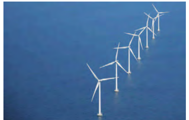
開発推進されている洋上風力発電施設（出典：DEA）
