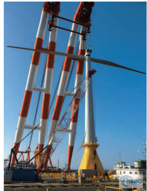
図3-2-10 タワーの設置状況 (出典：NEDO)
