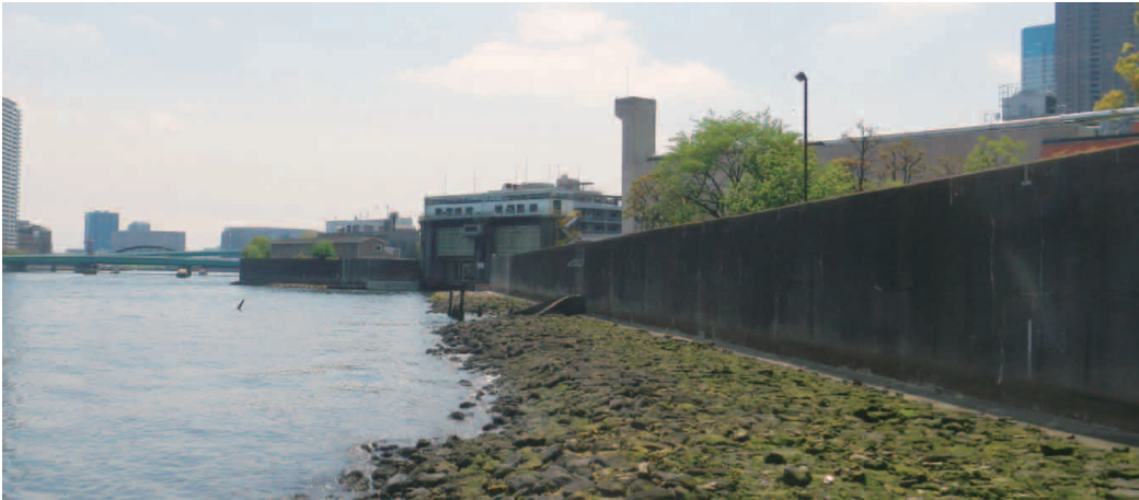
図4-1-7 高潮防潮堤（右側のコンクリート壁）と高潮防潮水門（中央の構造物）を組み合わせで建設した事例
