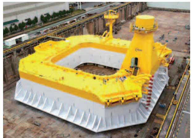
完成した次世代浮体式洋上風力発電システムのバージ型浮体 (出典：NEDO)
