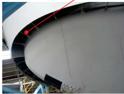
溝型波消し装置
