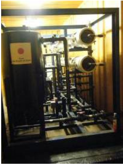
海水淡水化装置
