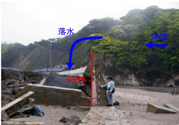
写真 2-5 コンクリート製堤防の崩壊
