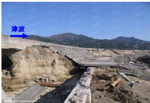
写真 2-6 土塁堤防の崩壊
