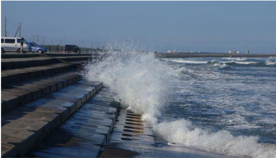
写真 2-4 千葉県一宮海岸の土地利用と緩傾斜護岸
