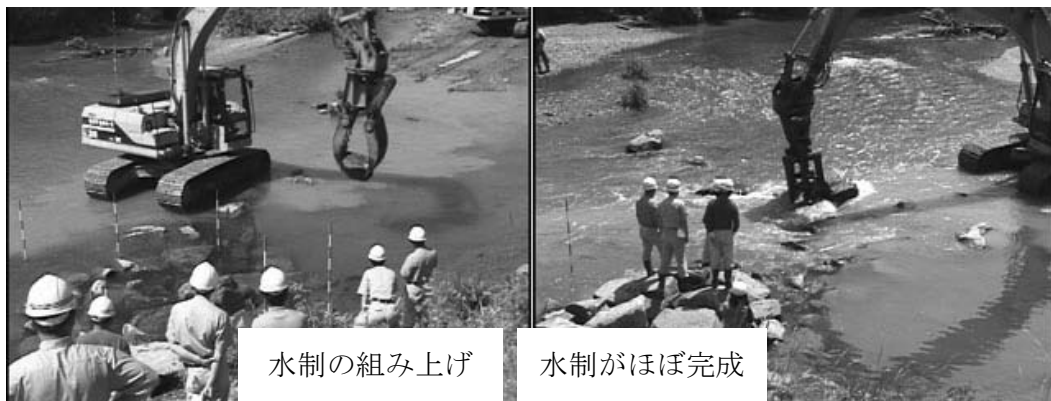
図 3-4-6 大畑川における近自然河川工法の現地実習
