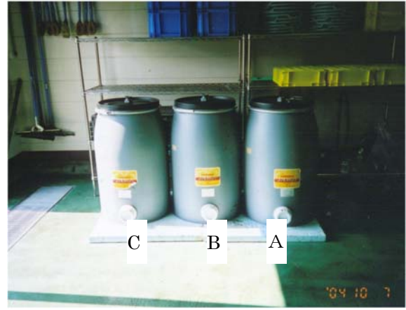
写真5. 2. 5 宗谷海岸建家の腐敗タンク
