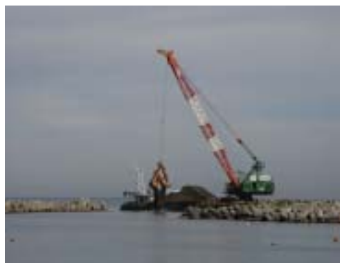
関屋浜海水浴場の沖合で、作業をする土砂運搬船
