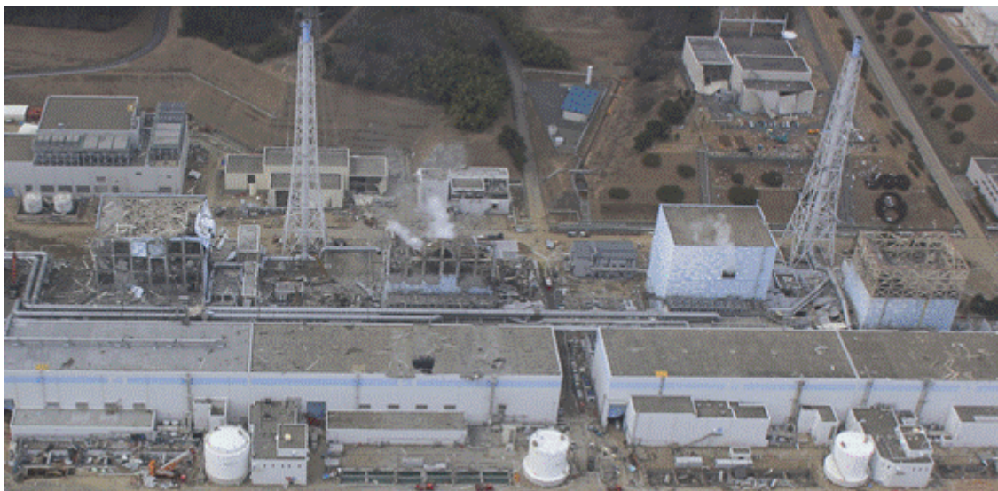
(2011年3月20日時点、右から1、2、3、4号機で、手前にタービン建屋が並ぶ。手前が海側)
